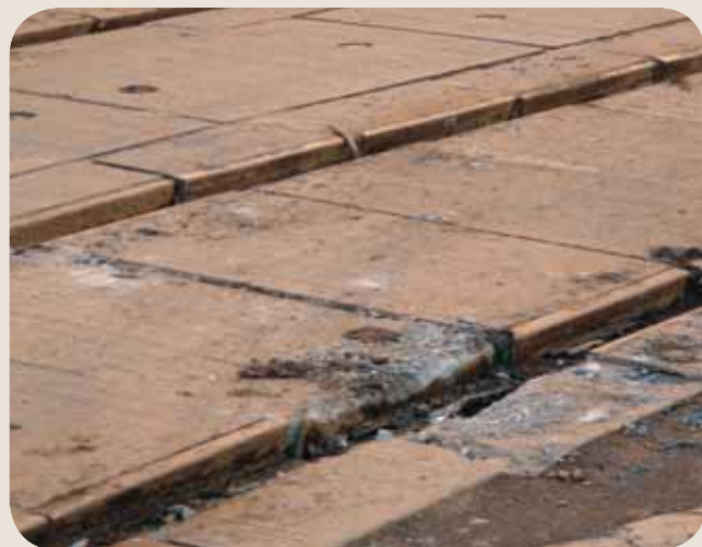
↓ Stejné místo po vyjmutí kolejnic.
