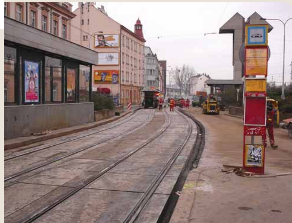
↓ Opravená trať ve stadiu dokončovacích prací.
