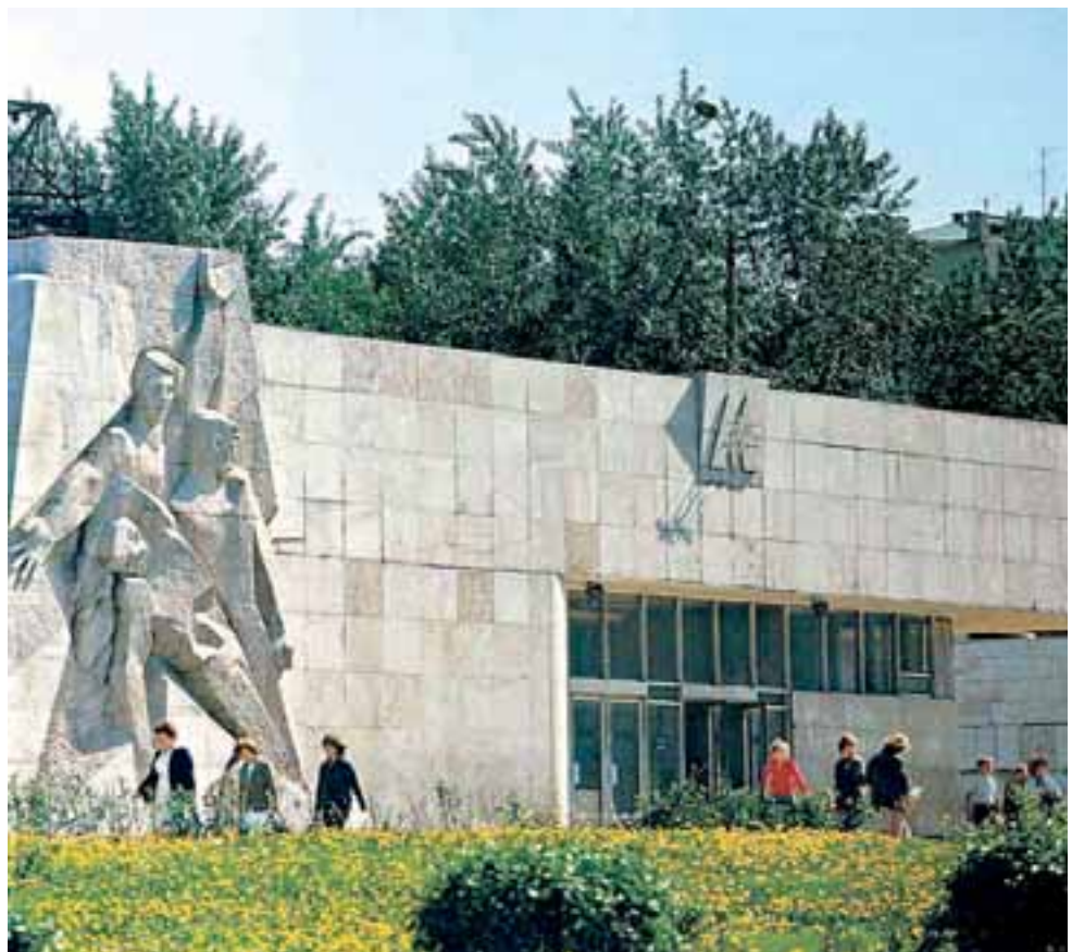
Vchod do stanice Barikádnaja otevřený v roce 1972.
