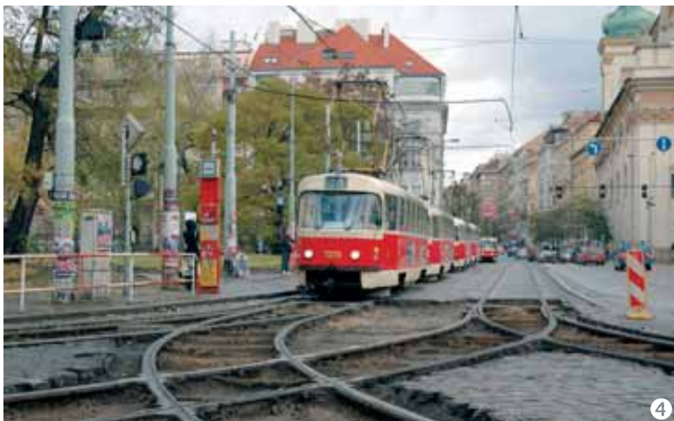
Vyjmutí dlažby za provozu. Foto © Jiří Beneš
