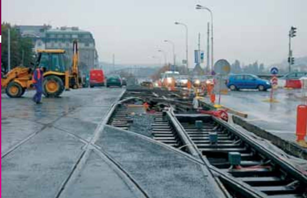
V současné době probíhá rozsáhlá rekonstrukce tramvajové trati na Palackého náměstí. Foto © Jan Horský
