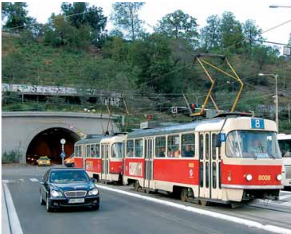
Na Štefáníkově mostě skončila rekonstrukce a tak tramvaje zde mohou po prázdninách opět jezdit. Foto © Jan Horský
