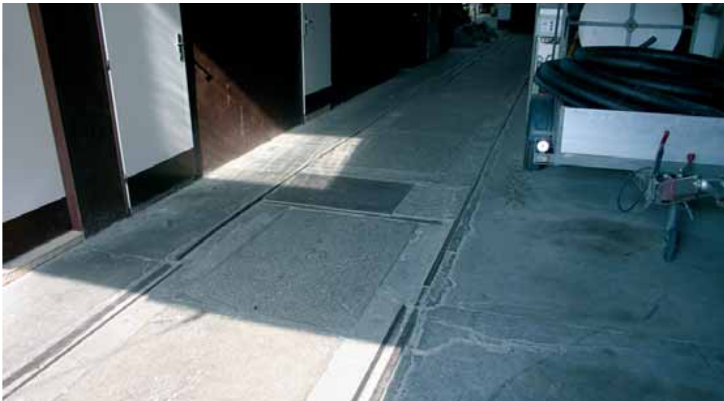
Toto je zřejmě poslední kolej v Praze, která ještě pamatuje počátky Dopravního podniku. Byly zde použity vignolové kolejnice nezvykle malého profilu 70 x 64 mm, s hlavou širokou pouhých 36 mm. Proto musely být podepřeny ještě traverzami tvaru I 80 x 150 mm. Jsou tedy staré 110 let.
