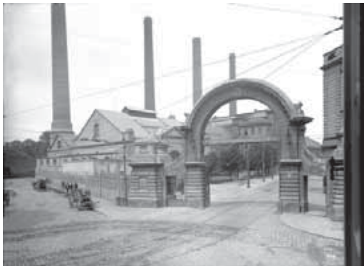
Elektrické podniky v roce 1900 uvedly do provozu holešovickou elektrárnu. Vyráběla proud nejen pro tramvaje, ale i pro veřejné osvětlení a „soukromý konzum“. Stala se na mnoho let doslova energetickým srdcem Prahy. V areálu byla také tramvajová vozovna a ústřední dílny pro opravu tramvajů.
