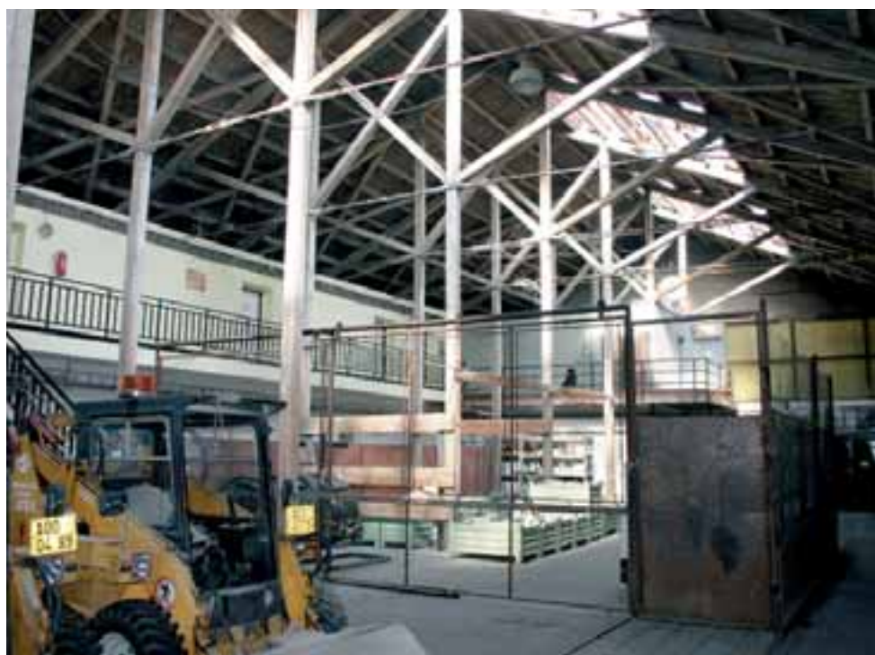
Charakteristické pro 110 let starou halu je dřevěná střešní konstrukce podepřená sloupy. Původní interiér je už dlouhá léta znehodnocen různými poválečnými vestavbami, jejichž účel se během let měnil.
