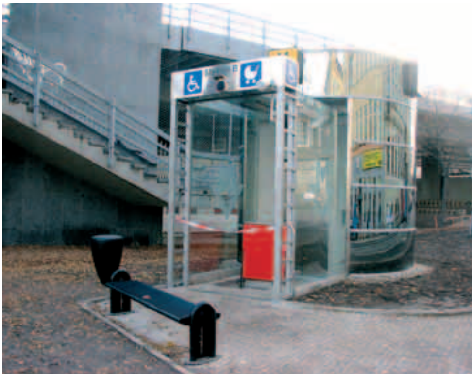
Povrchový kiosky u stanice metra Florenc B.
