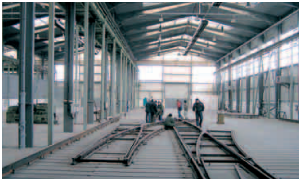
Celkový pohled do ještě „nezabydlené“ nové haly ve Víně s první kolejovou konstrukcí.
