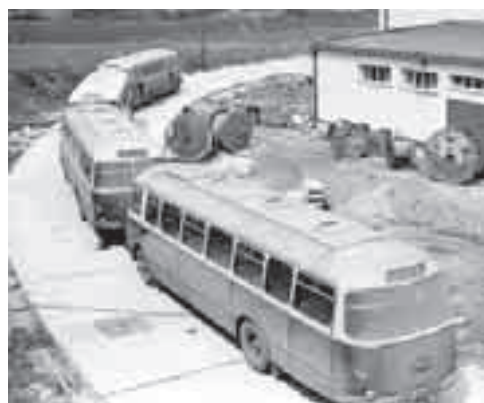
Garáž se dávala do užívání, ale jak je patrné z fotografie, k doděláním tu bylo opravdu mnoho. Hala se tehdy objížděla po provizorní vozovce.
