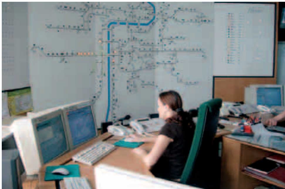
Zkoušky dálkového ovládání z energetického dispečinku tramvají v Centrálním dispečinku.
