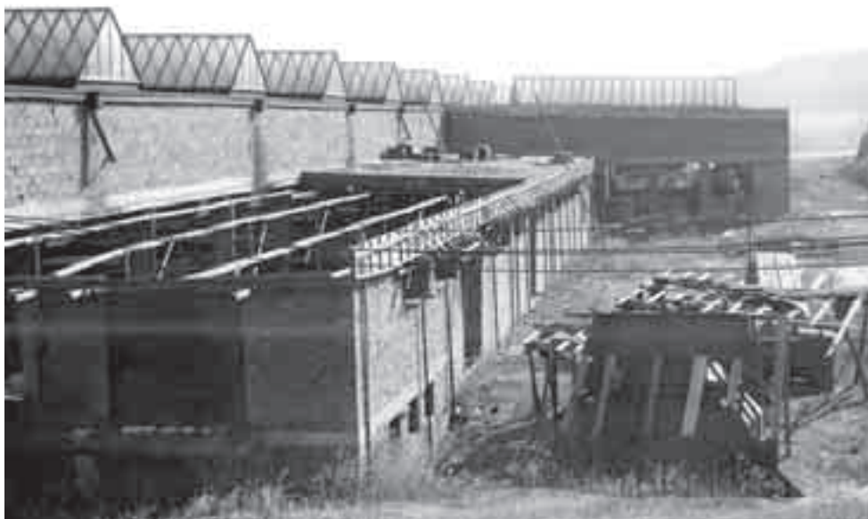
Lidé se ze staveniště garáže od rozdělané práce doslova vypařili. Tři roky tu byl naprostý klid.
