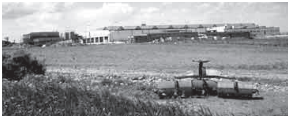
Garáž Kačerov v květnu 1966 čeká na zahájení provozu. Tehdy stála doslova v polích.
