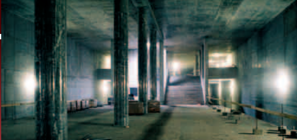
Stanice Letňany – nástupiště.
