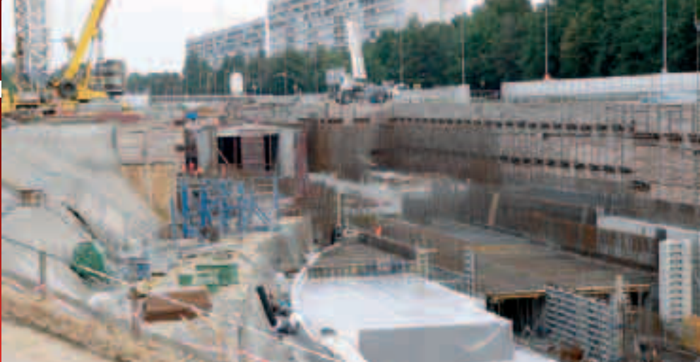
Výstavba metra na Proseku.
