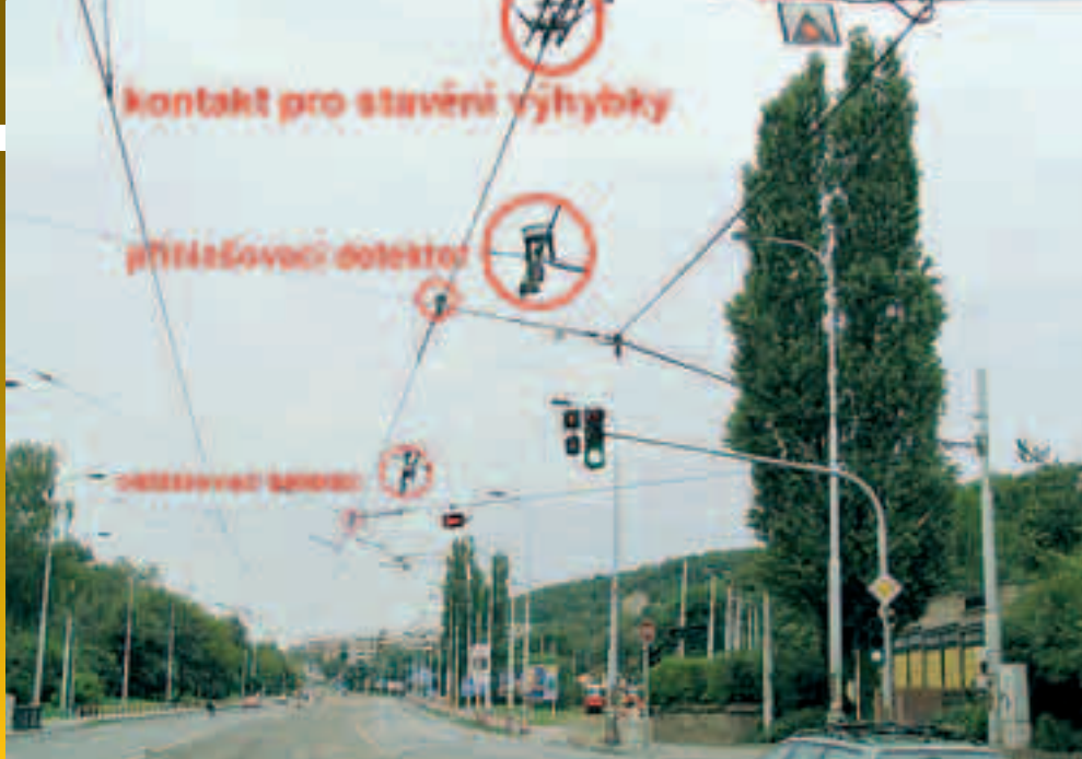
SSZ Plzeňská – vjezd na smyčku Kotlářka: pohled na trolejovou detekci.
