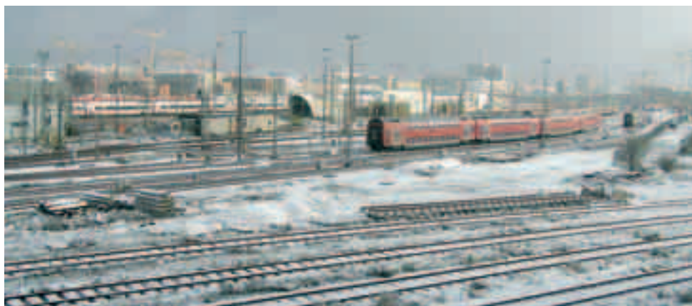
Kolejiště, v pozadí S-Bahn.
