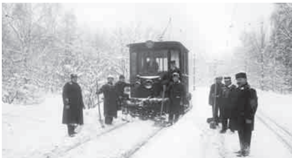
Jeden ze sněhových pluhů v Královské oboře. Původně byly vozy otevřené a jejich obsluha nebyla nijak chráněna před nepřízní počasí. Proto byly dodatečně všechny pluhy uzavřeny. Foto © Archiv
