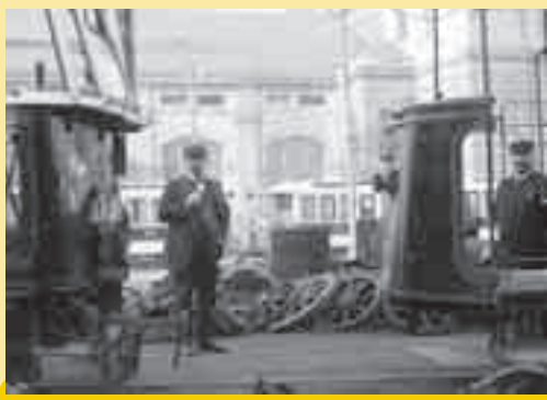
Dvůr Centrály byl v době, kdy zde byly i dílny, neustále plný nabouraných a odstavených tramvají i různých demontovaných součástí vozů. Na snímku ze 7. října 1913 A. Novotný zachytil v pozadí mezi dvěma vozy poškozenými při nehodě částečně i vlečné vozy č. 532 a 569, které původně jezdily na koňce.
