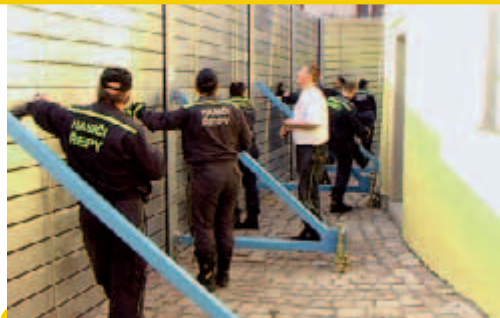
Zkušební stavba mobilního hrazení na Kampě.
