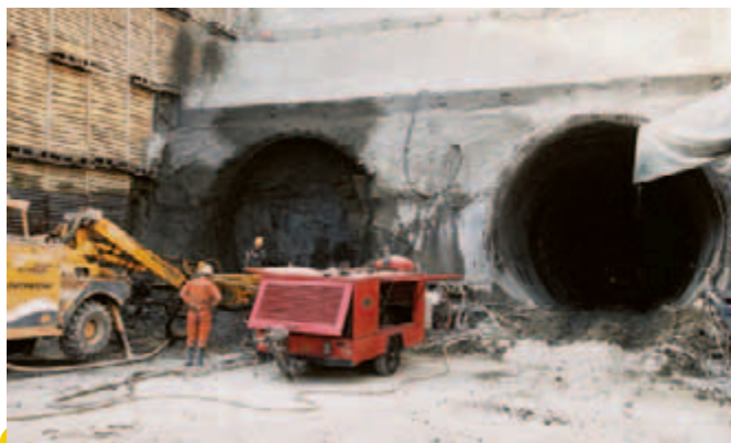
Portály budoucích ražených traťových tunelů.
