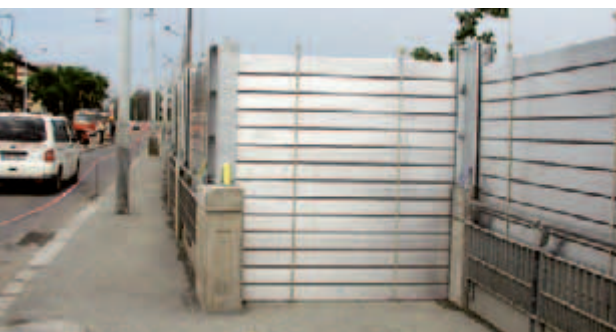
Namontované mobilní hrazení u Argentinské ulice v rámci předání stavby
