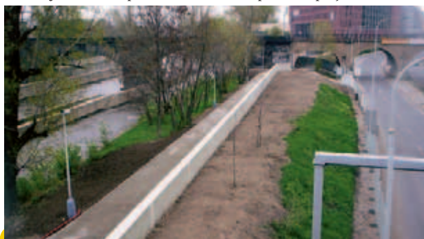
Dokončená zídka s cyklostezkou mezi terasami Hilton a Negrelliho viaduktem
