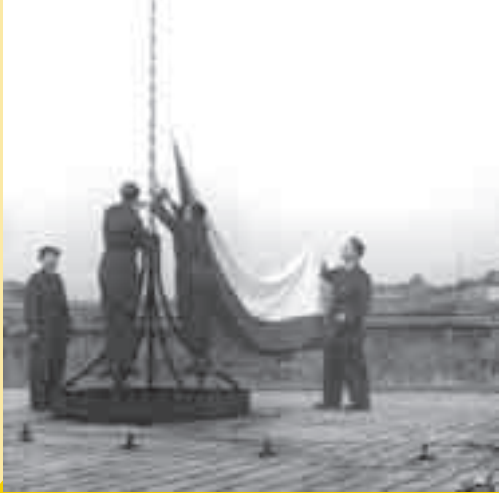
Květen 1945 na střeše Ústřední budovy Elektrických podniků. Zaměstnanci podniku vztyčují státní vlajku na znamení svobody.
