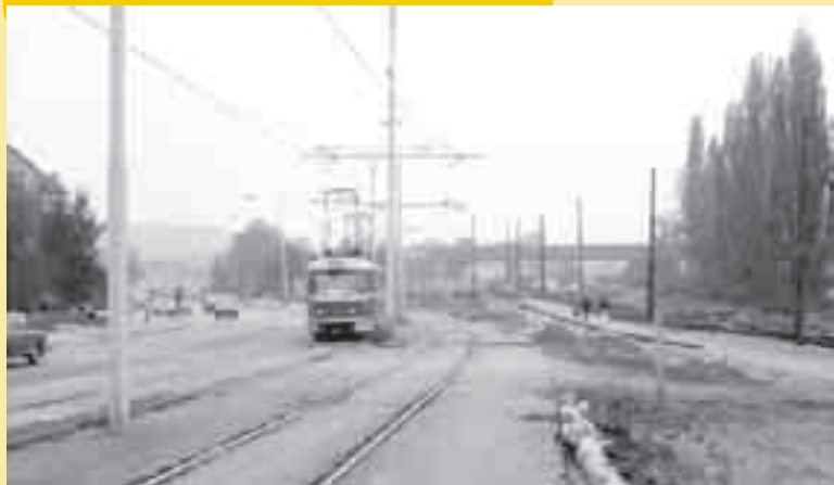
Říjen 1986. Pohled z křižovatky u Jezerky směrem k mostu Antonína Zápotockého. Vlevo ulice Na Mlejnku, vpravo rozestavěná přeložka.
