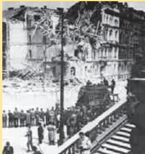
Tato fotografie patří mezi všeobecně známé, ale zatím zřejmě nikdo nekomentoval, že na ní jsou zachyceni i zaměstnanci Elektrických podniků opravující trolejové vedení. Snímek vystihuje leták Elektrických podniků z úvodu článku. Lidé se dívají na trosky, tramvajáci pracují...
