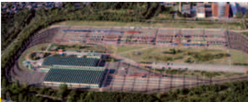
Nejmladší vozovnou je Marheim postavená v letech 1989 až 1994. V kryté části jsou koleje pro běžné opravy a údržbu. Deponovací kapacita podle otevřeným nebem je 200 tramvajových vlaků.
