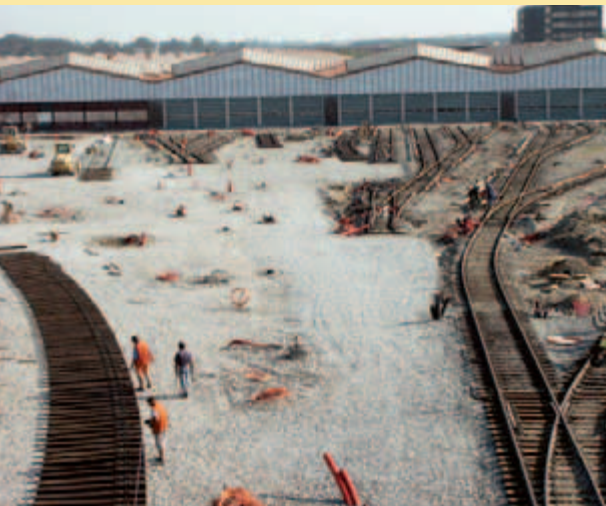
Celkový pohled k hale. Pouze pravá část kolejového svršku zůstane původní. S kolejovým svrškem se mění i kolejový spodek.
