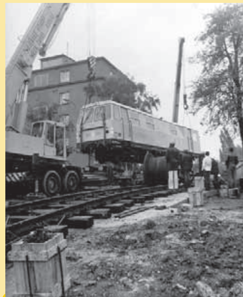
Zde byl vůz vyzdvižen dvojicí jeřábů a usazen na provizorní kolej...
