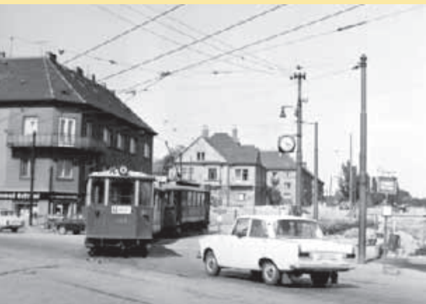
Fotografie z konečné v Čimické ulici bohužel žádné neznáme. Připomeňme si proto alespoň smyčku Střelničná z doby, kdy se začala rekonstruovat Střelničná a stavět na sklonku 60. let 20. století nová trať na sidiště Ďáblice. Foto: J. Bureš
