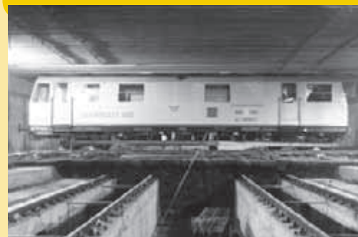
Do podzemí se svařovací vůz dostal kolmo na budoucí obrátové a odstavné koleje stanice. A co bylo dál? Toto je poslední snímek, který máme zatím k dispozici. Jak se vůz v podzemí otočil a dostal na koleje, aby mohl začít plnit svůj úkol? Možná nám to někdo připomene.
