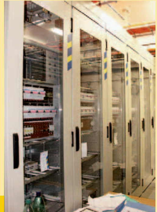
Skříně pro umístění počítačů elektronického stavědla.
