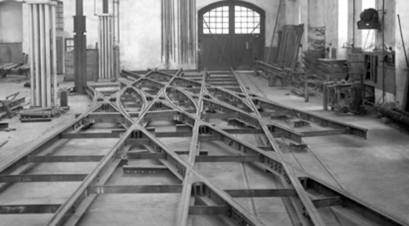
Tak vypadala dvojice „angličanů“ jako součást křížení tramvajových tratí na náměstí Míru v roce 1920, pracovně smontovaná v dílnách kolejových konstrukcí v Rustonce před odvozem na místo určení.
