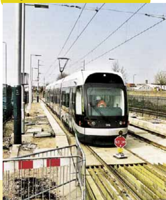
Výstavba systému městské kolejové dopravy v anglickém Nottinghamu.
