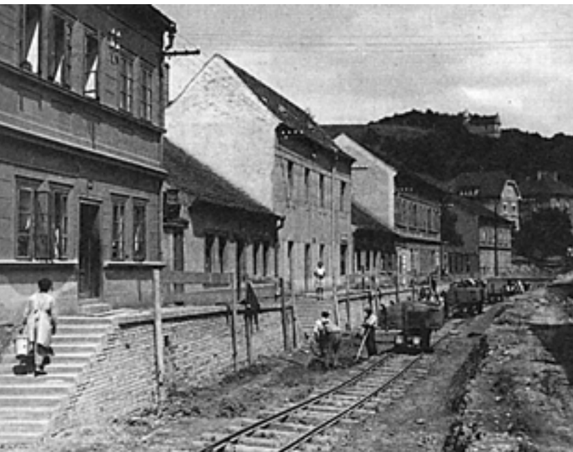
Při odkopávání terénu mezi domy vedla dnešní ulicí U Plynárny ve dvacátých letech 20. století kolej průmyslové dráhy, po které se odkopaný materiál odvážel.
