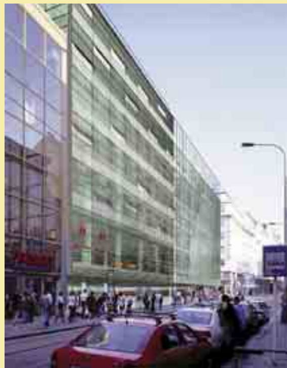
Pohled ze Spálené ulice.
