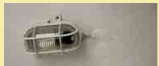
Výsledek následné opravy.
