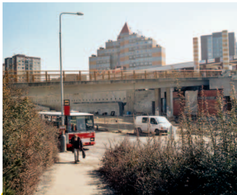
Stejně místo v březnu 2003. Pod lávkou pro pěší je již staveniště, ale nic ještě nepřipomíná budoucí podobu tramvajové zastávky.
