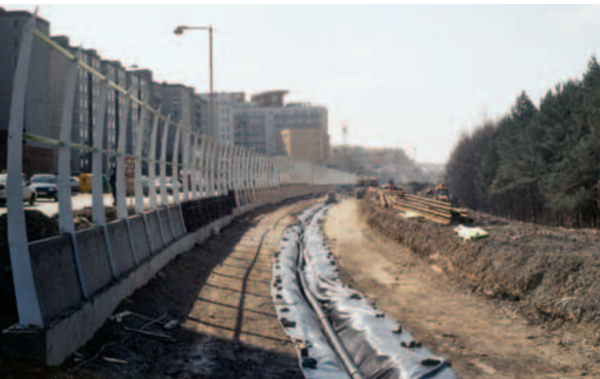
Traťový úsek podél Werichovy ulice, kde je postavena protihluková stěna, v březnu 2003...
