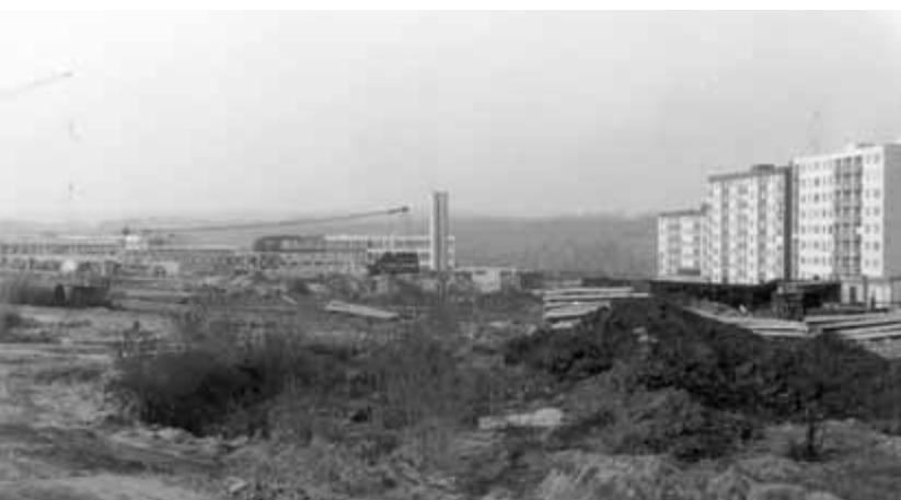
Dreyerova ulice v srpnu 1985. Dnes už by do ní takhle od magistrály vidět nebylo, protože tu stojí další dům. V místech, kde jsou panely složené k jeho stavbě, je dnes zahlobbená tramvajová zastávka K Barrandovu.
