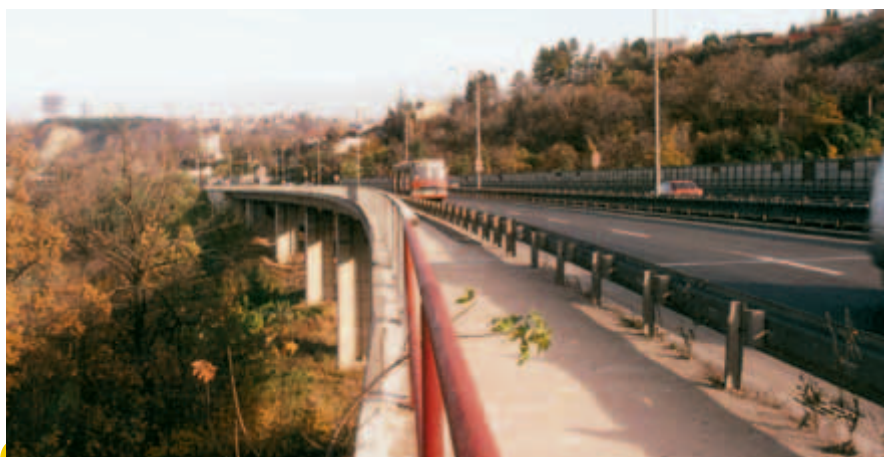
Silniční estakáda přes Růžičkovu rokli na podzim 1996. Je sobota odpoledne, na magistrále je nezvyklý klid. Dnes je vlevo tramvajová estakáda.
