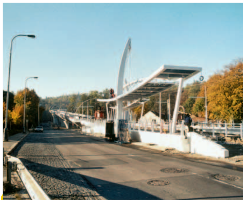
...a stejné místo v říjnu 2003. Tady začíná dosud nejnáročnější stavba tramvajové tratě.
