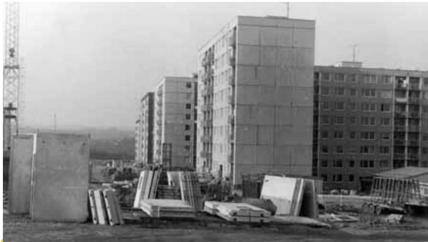
Sídlíště Barrandov, konec srpna 1985. V pozadí dokončovaná škola na budoucím Chaplinově náměstí, upravo první domy v severní polovině Dreyerovy ulice.
