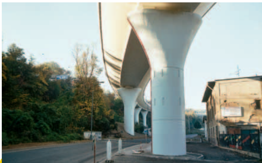
Před lety se mnoho obyvatel sídliště ptalo, jak se tramvaje dostanou nahoru. Ten úkol plní dvě estakády přes údolí Hlubočepského potoka a přes Růžičkovu rokli. Hlubočepská (na snímku) je dlouhá 467 m a dosahuje výšky až 19 m.
