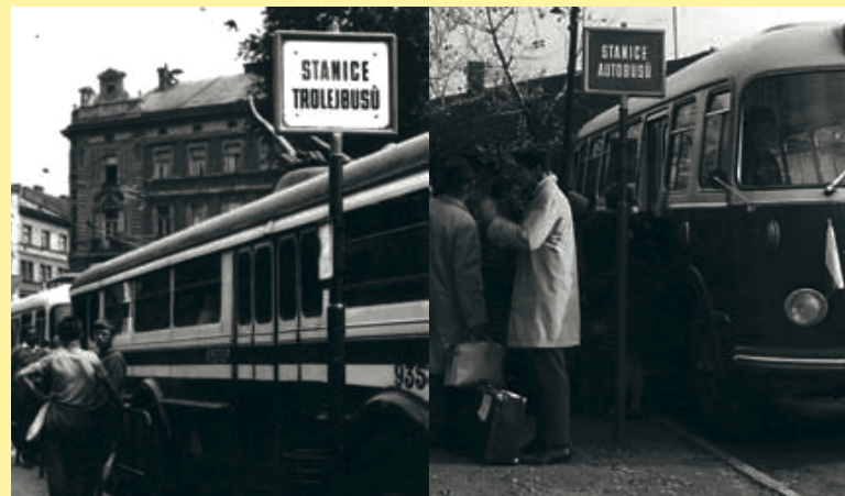
Staniční tabulky pro autobusy a trolejbusy. Je už patrný ústup od ozdobných litinových rámužíž užívaných od počátku století a přechod k rámužíž trubkovým.
