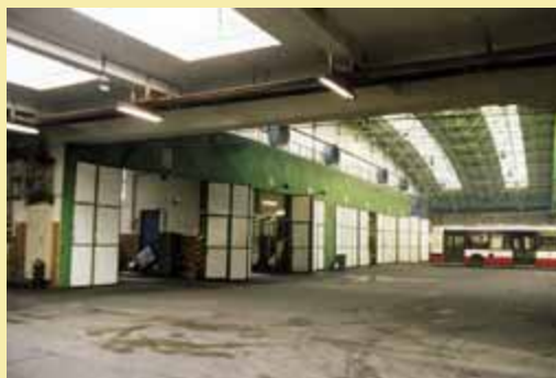
Dílny na západní straně budovy od haly původně neoddělovala žádná příčka (ta byla postavena až v roce 1968) a byly vybaveny 9 revizními šachtami a jedním hydraulickým zvedákem o nosnosti 8 - 10 tun. Čtyři šachty byly propojeny průběžným kanálem.
