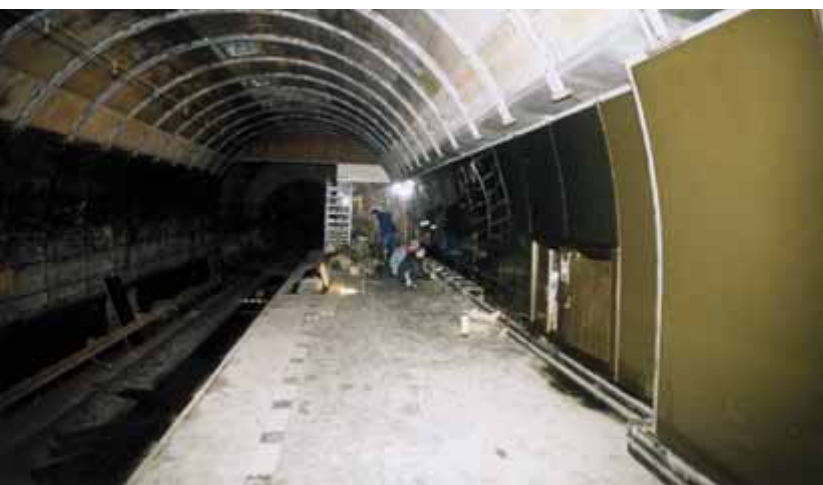
Rovněž ve stanici Náměstí Republiky se pracuje na uvedení do původního stavu.
