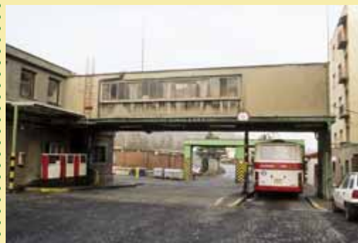
Čerpací stanice pohonných hmot je 70 let na svém místě, ale dnes je vybavena klasickými stojany.
