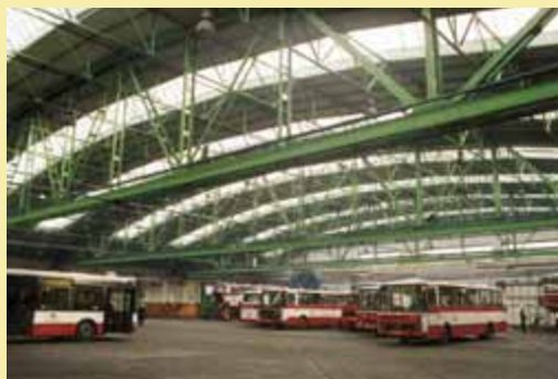
Prostorná hala má dodnes původní podlahu. Jen na několika málo místech bylo nutné ji opravit. Dodnes se v ní dochovaly i původní kovové parkovací značky.
