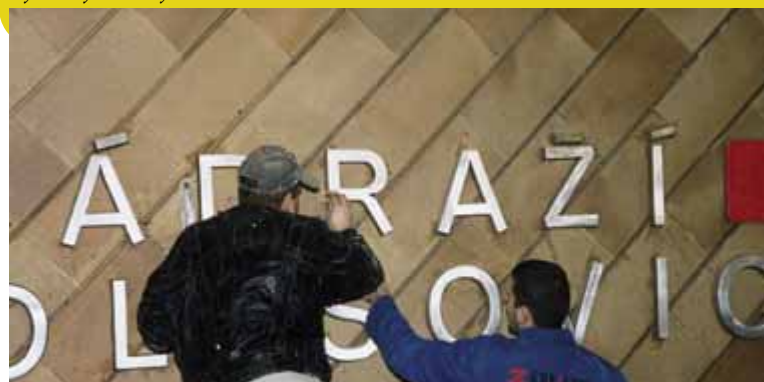
Vycíděný musí být i název stanice na stěnách.
