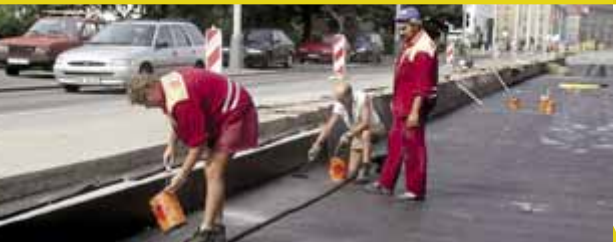
Montáž podštěrkových rohoží firmy PHOENIX, vyfoceno 2. srpna letošního roku.
