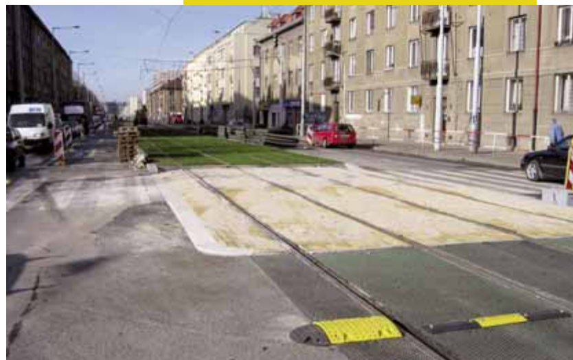
Pohled na různé typy zákrytu tramvajové tratě u Limuzské ulice.
