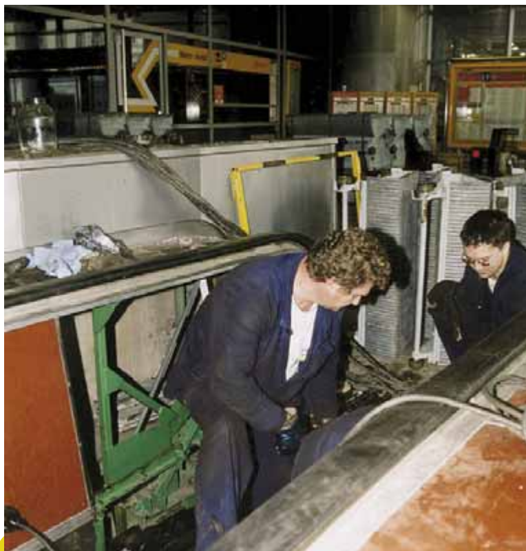
U Anděla už se pracuje i na eskalátorech, které jsou omezujícím prvkem v rekonstrukcích mnoha stanic.
