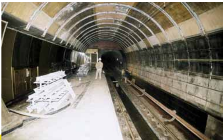
Pracuje se nejen na nástupišti, ale i v kolejišti. Vlaky stanice začnou projíždět koncem ledna a o měsíc později bude otevřena i pro cestující.
