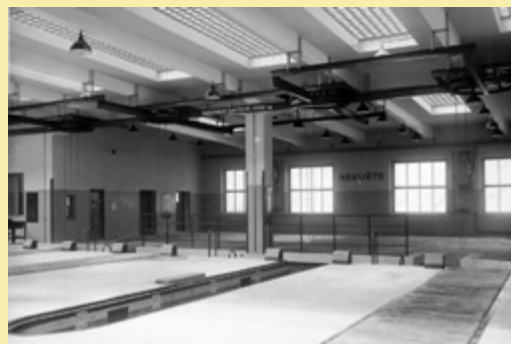
Dílny na západní straně budovy od haly původně neoddělovala žádná příčka (ta byla postavena až v roce 1968) a byly vybaveny 9 revizními šachtami a jedním hydraulickým zvedákem o nosnosti 8 - 10 tun. Čtyři šachty byly propojeny průběžným kanálem.
