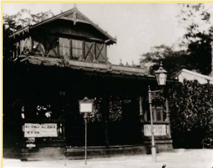
Tento snímek byl pořízen současně s předchozím a měl zřejmě zadokumentovat budovu čekárny před zbořením.
