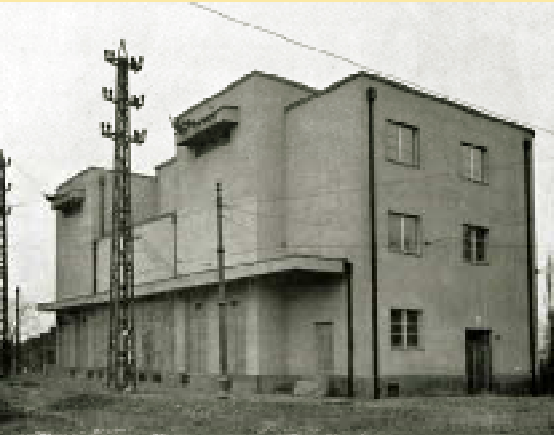
Transformační stanice a měnična Zelená liška v roce 1931. Na snímku je patrné i trolejové vedení nad nákladní kolejí k transformátorové rampě. Foto: sbírka autora
