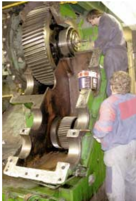
Rekonstrukce převodového soustrojí u Anděla.
