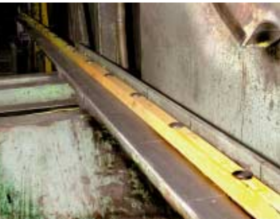
Montáž solidurových vodících lišt dráhového systému u Anděla.
