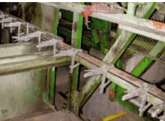
Lepení solidurových pásů na dráhový systém ve stanici Anděl.
