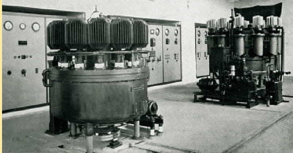
Původní rtuťové usměrňovače v měničně Zelená liška.
