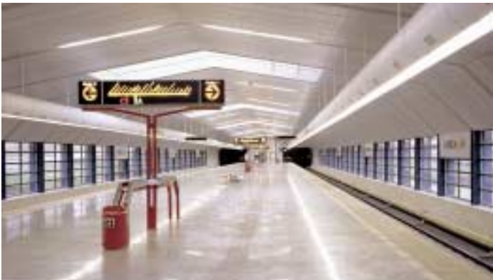
Stanice Luka na 5. úseku tratě B.
