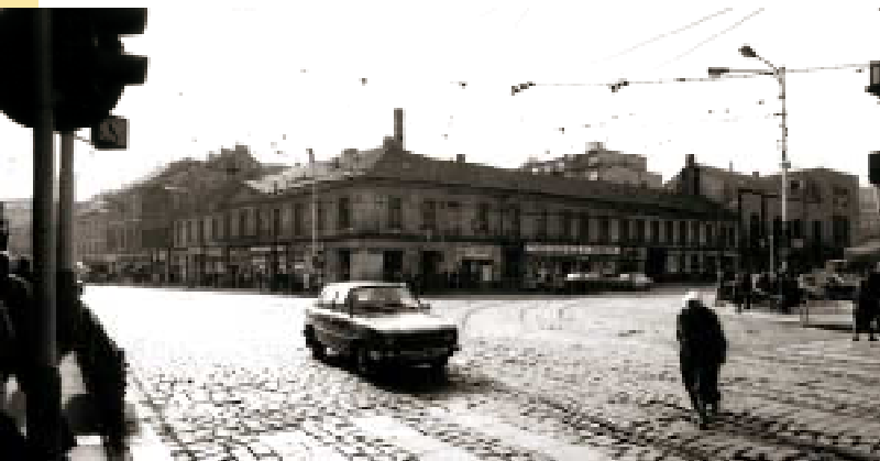
Křižovatka Anděl před zahájením stavby metra (70. léta 20. století).
