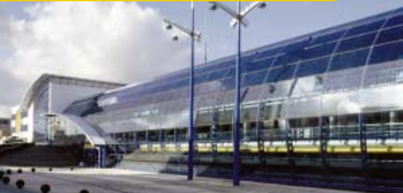
Pohled na stanici Rajska zahrada.
