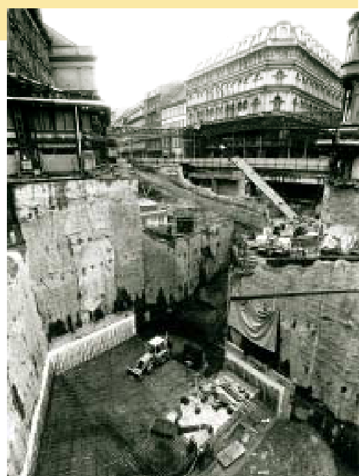
Práce ve stavební jámě podchodu na Junfgmannovae náměstí (první polovina 80. let 20. století).
