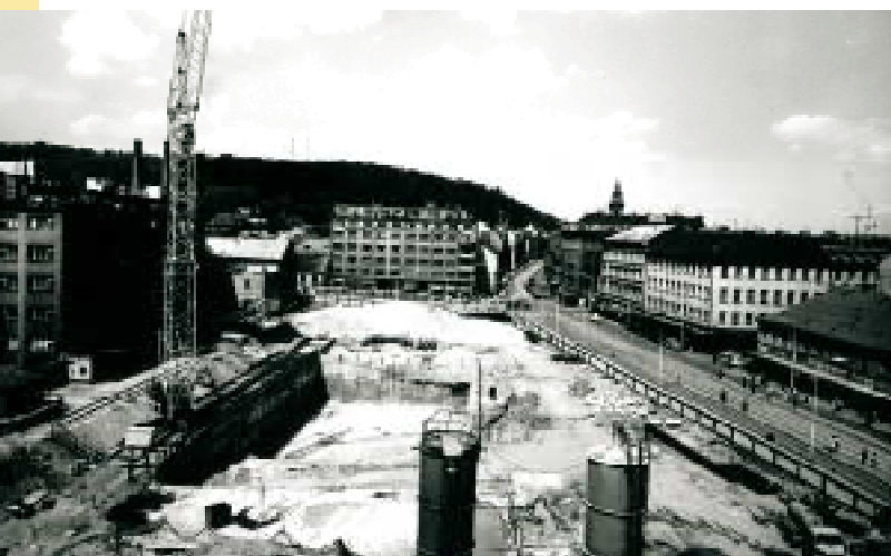
Stavební jáma vestibulu u Anděla (1. polovina 80. let 20. století).
