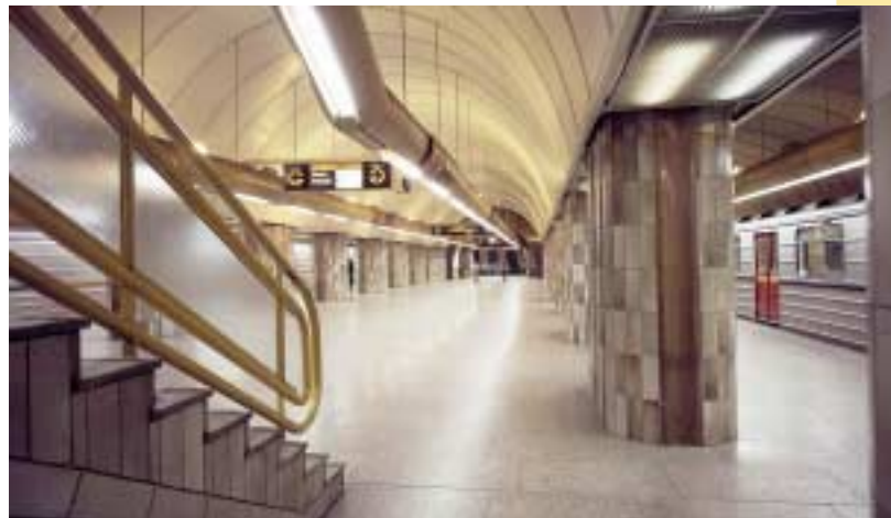
Zařízení přestupního schodiště do střední lodi stanice Florenc.
